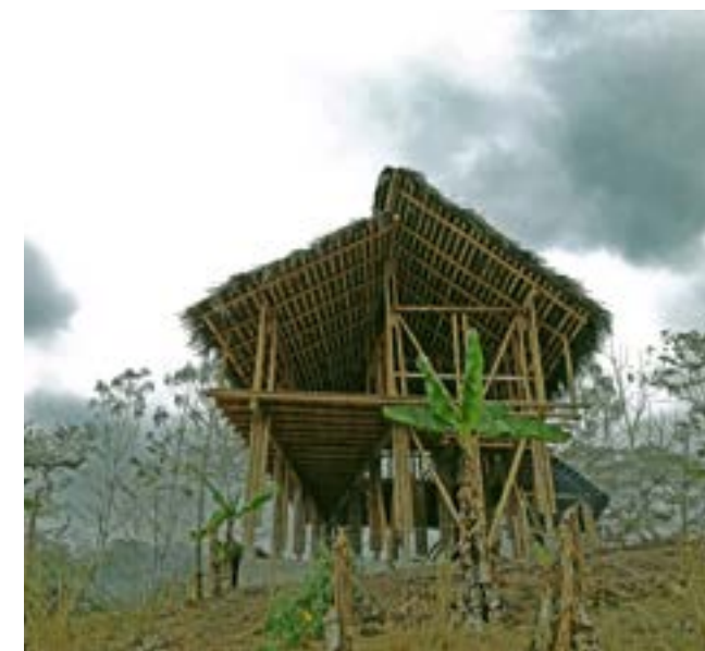
Fig.3 Prospetto est della struttura
