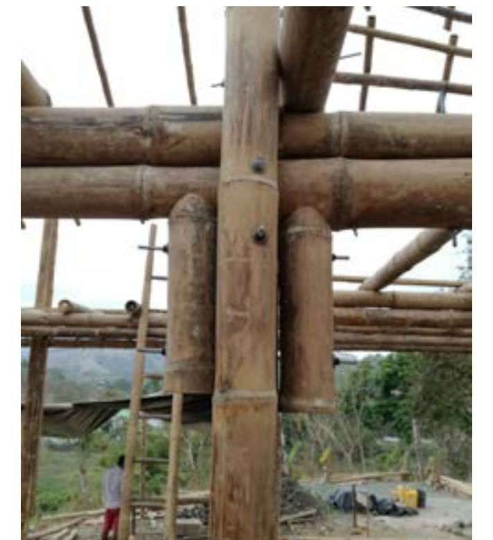
Fig.4 Dettaglio unione pilastro-solaio
