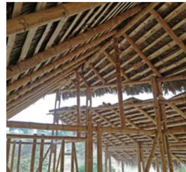
Fig.2 Particolare del taglio in copertura
