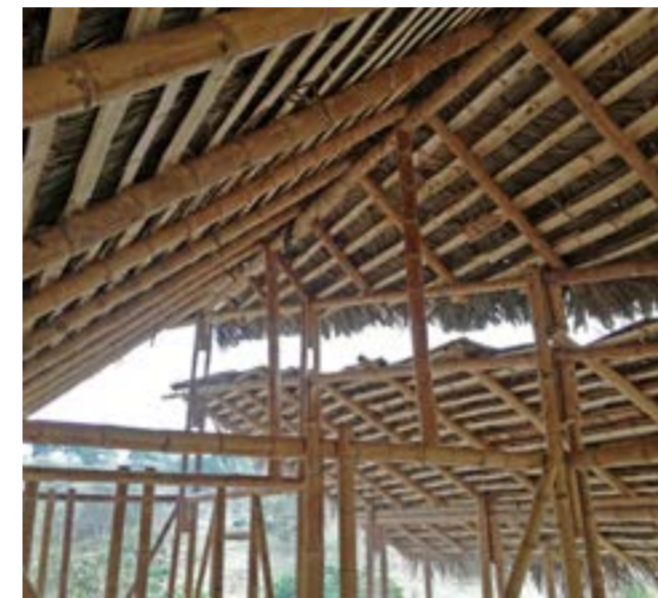
Fig.2 Particolare del taglio in copertura
