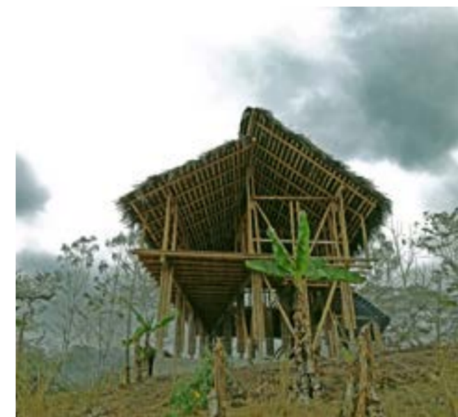
Fig.3 Prospetto est della struttura
