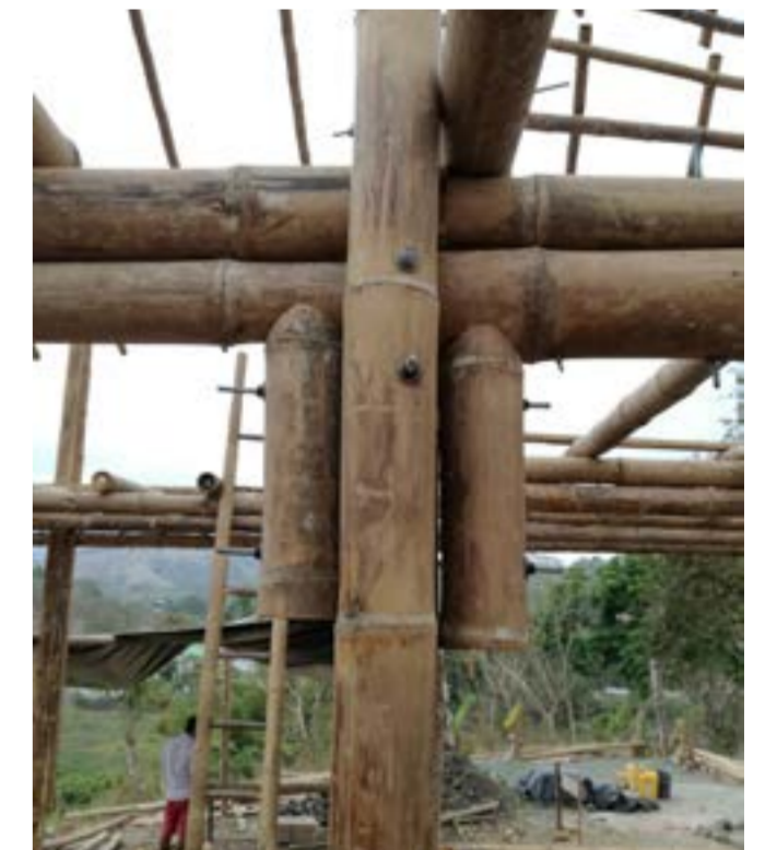
Fig.4 Dettaglio unione pilastro-solaio
