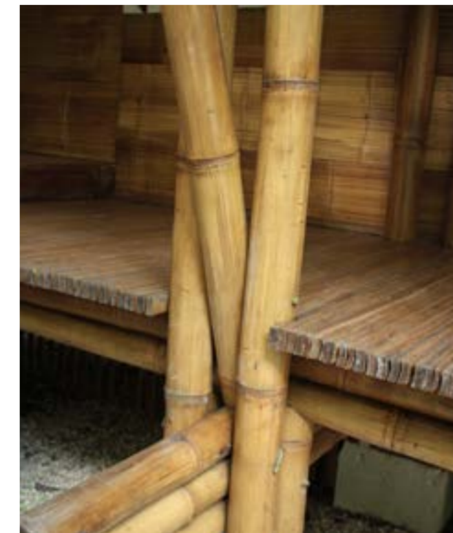
Fig.7 Collegamento pilastro-trave a terra
