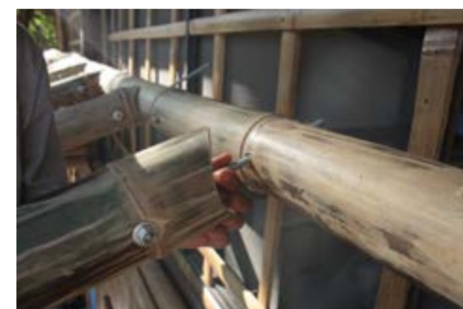
Fig.4 Dettaglio del collegamento a "bocca di pesce"
