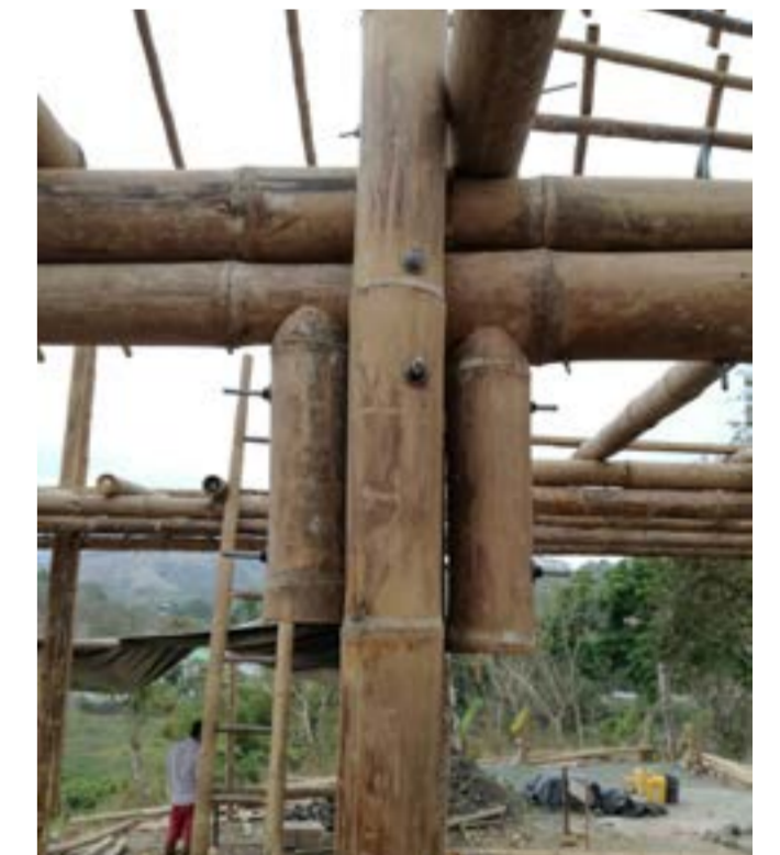
Fig.4 Dettaglio unione pilastro-solaio
