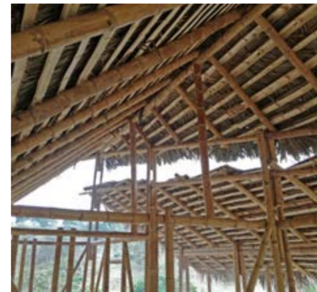
Fig.2 Particolare del taglio in copertura
