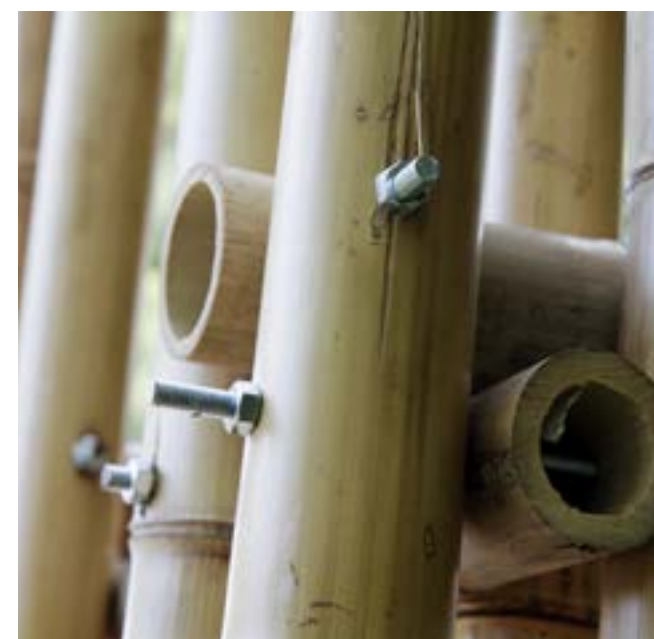
Fig.6 Dettagli del nodo pilastro-trave
