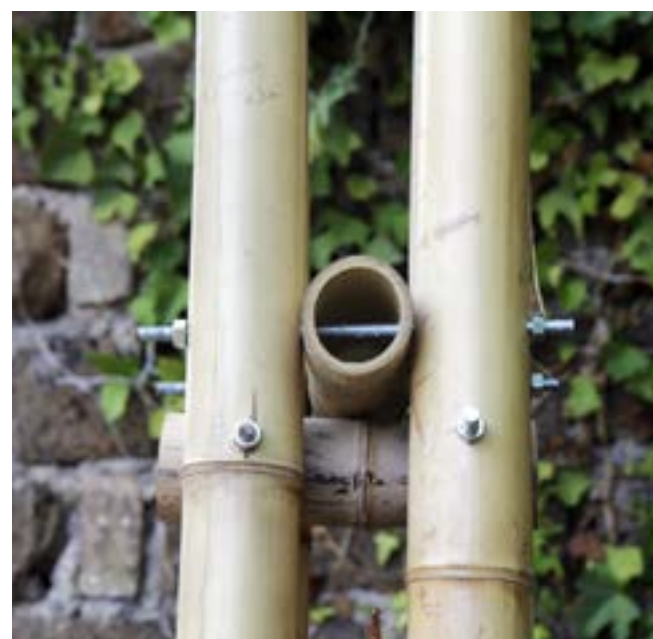
Fig.5 Dettagli del nodo pilastro-trave
