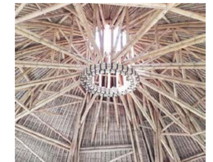
Fig.11 Yoga Shala - Dettaglio della copertura
