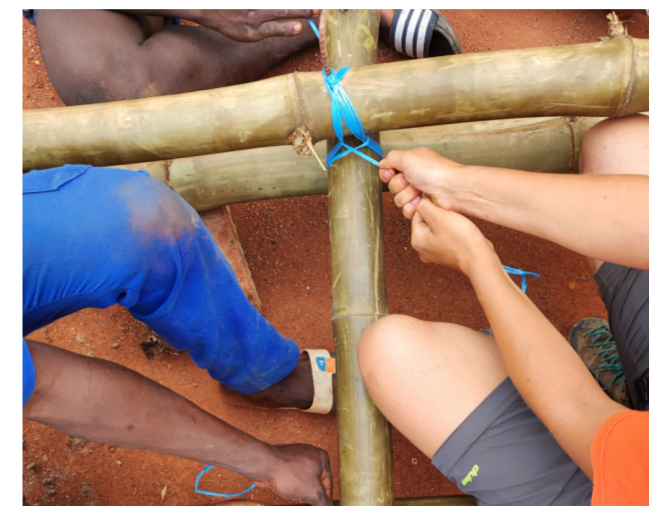
Fig.2 Prototipo del solaio in bambù e terra
